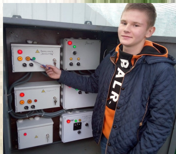
Рис. 3. Щит автоматичного управління мікрокліматом
